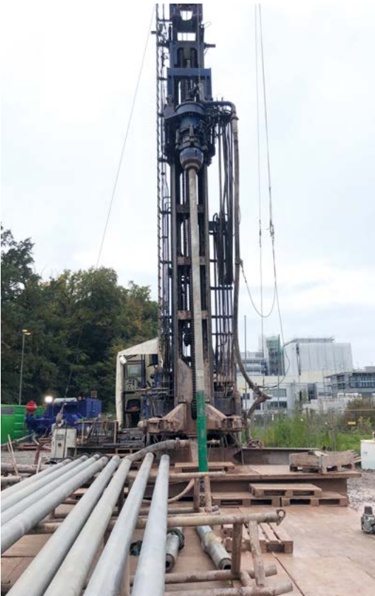
Abbildung 1: Einbau des Prototypen auf einer Bohrung an der TU Darmstadt.
